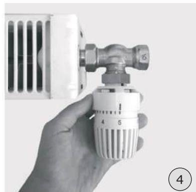
1. Снимите защитный колпачок с термостатического клапана.
