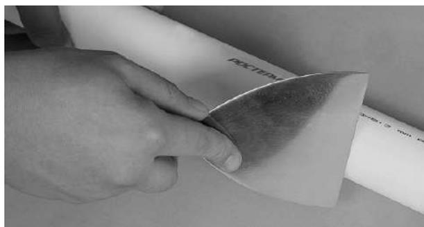
Рекомендуется электросварные муфты до начала монтажа оставлять в оригинальной полиэтиленовой оболочке для того, чтобы не загрязнить и не повредить внутренний слой нагревательной спирали. В противном случае монтаж приведет к некачественной сварке.
