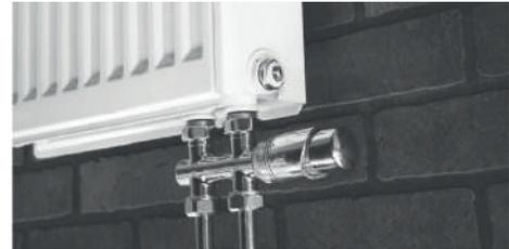
Непосредственное подключение трубы к радиатору с помощью H-образной гарнитуры и медных L- и Т-образных трубок
