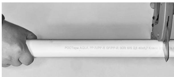
2. Перед свариванием с обоих концов труб снимается верхний слой не более 0,1 мм (скребком или специальным рубанком).
