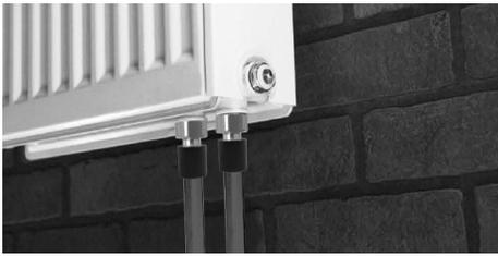
Непосредственное подключение трубы к радиатору с помощью медных L- и Т-образных трубок
