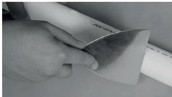
После предварительного осмотра в случае необходимости трубы нужно отрезать при помощи специальных режущих приборов (ножницы или труборез, в зависимости от диаметра) строго под углом 90 °, образовавшиеся заусенцы и стружку нужно удалить. При помощи маркера рекомендуется обозначить глубину сварки на конце трубы. При этом нужно учитывать, что труба не должна быть вставлена до упора в муфту фитинга с целью предотвращения сужения проходного сечения в месте соединения (не более 1 мм).
