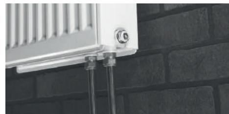
Непосредственное подключение трубы к радиатору с помощью резьбовых латунных фитингов
