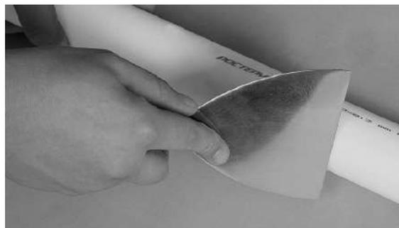
После предварительного осмотра в случае необходимости трубу нужно отрезать при помощи специальных режущих приборов (ножницы или труборез, в зависимости от диаметра) строго под углом 90°, образовавшиеся заусенцы и стружку нужно удалить. При помощи маркера рекомендуется обозначить глубину сварки на конце трубы. При этом нужно учитывать, что труба не должна быть вставлена до упора в муфту фитинга с целью предотвращения сужения проходного сечения в месте соединения (не более 1 мм).
