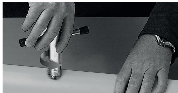
Спустя 30 секунд сварочный аппарат извлекается из тела трубы, а вварное седло извлекается с нагревательной плашки, после чего незамедлительно вставляется в нагретое отверстие трубы.
