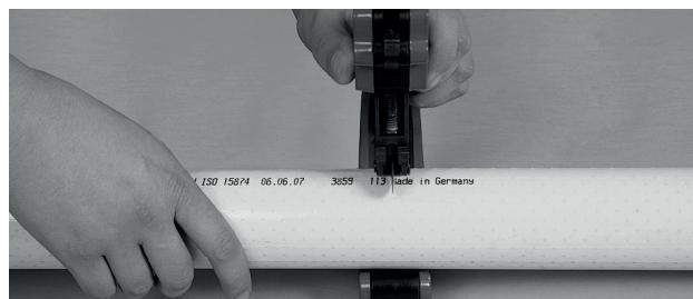
2. Перед свариванием с обоих концов труб снимается верхний слой не более 0,1 мм (скребком или специальным рубанком).
