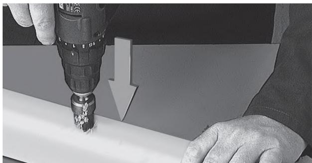
В трубах, в которые делается врезка, нужно просверлить соответствующее отверстие специальным инструментом (фреза).
