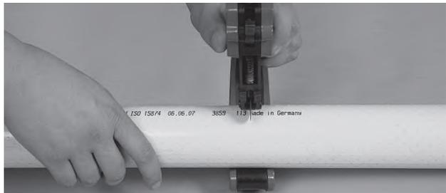
1. В случае необходимости, отрезать трубу строго под углом 90°.
