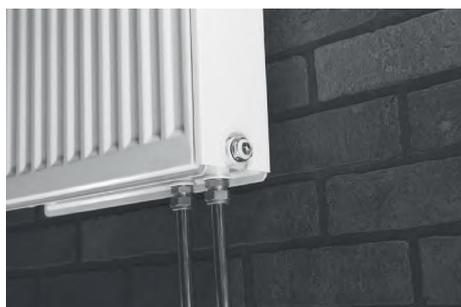
Непосредственное подключение трубы к радиатору с помощью медных L- и T-образных трубок
