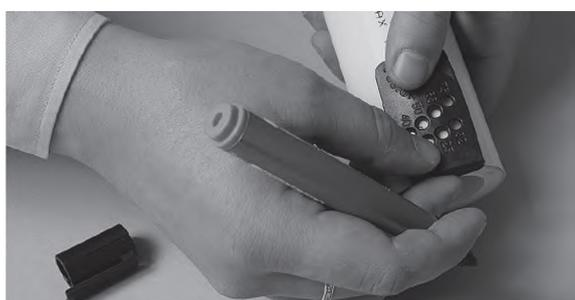
При помощи маркера рекомендуется обозначить глубину сварки на конце трубы. При этом нужно учитывать, что труба не должна быть вставлена до упора в муфту фитинга с целью предотвращения сужения проходного сечения в месте соединения (не более 1 мм).
