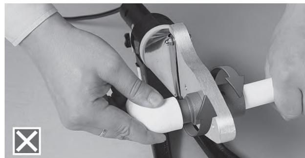
После окончания нагрева нужно снять трубу и фитинг с насадки и медленным поступательным движением произвести соединение элементов. Время с момента снятия с нагревательной плашки до момента соединения нагретых элементов не должно превышать указанного в таблице №5.
