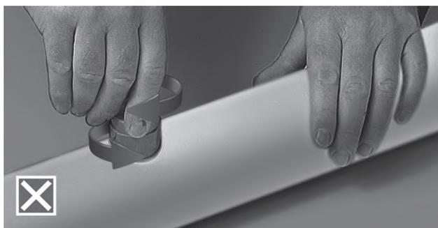
Затем седло следует точно и плотно, избегая вращения, прижать к нагретой наружной поверхности трубы, неподвижно фиксируя в течение 15 секунд.
