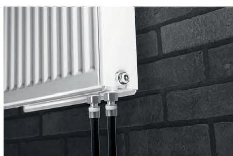
Непосредственное подключение трубы к радиатору с помощью резьбовых латунных фитингов
