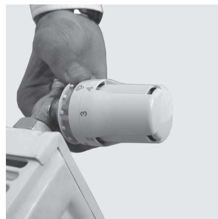
6. Поверните и установите блокирующие штифты напротив позиции «3».
