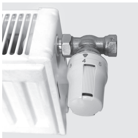
1. Установить настройку на термоголовке в положение «5»
